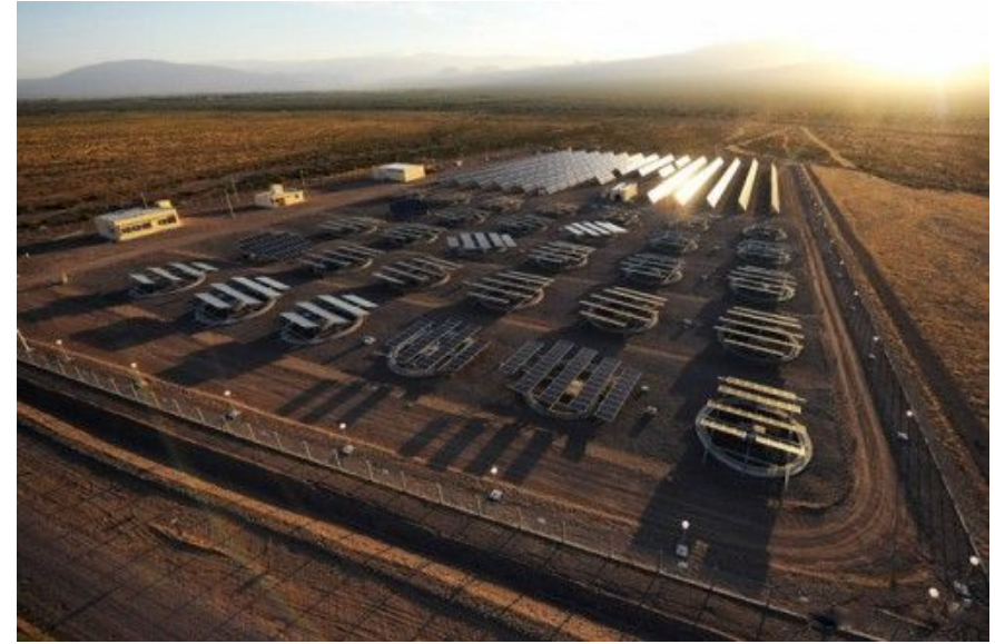
Planta de energía solar fotovoltaica Cañada Honda
